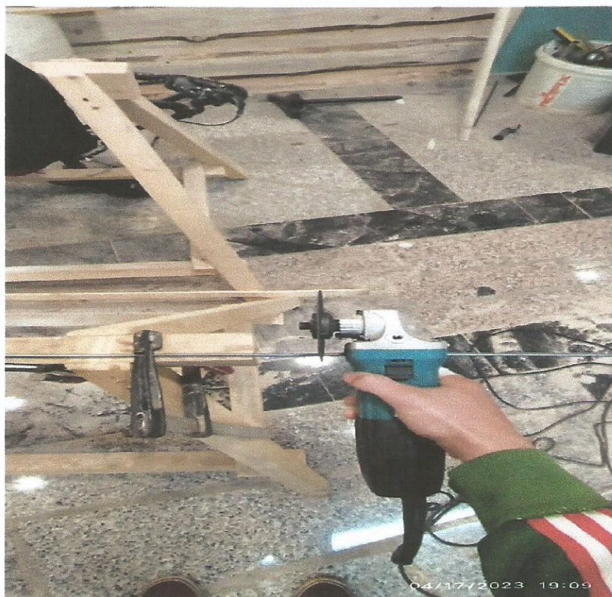
Slika 5. Rezanje metalnih dijelova
